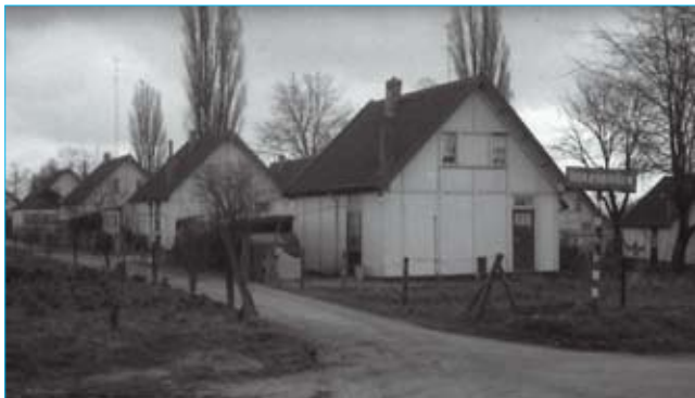
De asbestwoningen gezien vanaf de Groeneweg
